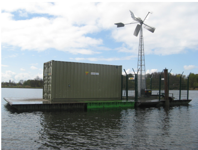
Afbeelding 1. Mobile doseerinstallatie met windmolen (Foto: Michel Colin)
